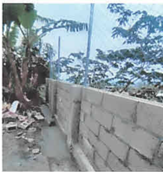
Foto 5: Culminación de construcción de muro perimetral con block, tubo y malla.
