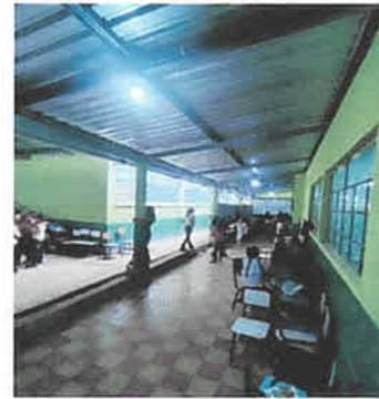
Foto 4: culminación de instalación de alumbrado eléctrico en pasillos con focos de luz blanca.
